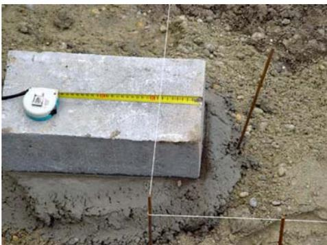
Отступите от края блока 8-10 см и начертите на бетонном блоке линию. По веревке нанесите разметку на все остальные блоки. Разметочная линия будет указывать на начало установки внутренней (лицевой) части многоразовой опалубки.
